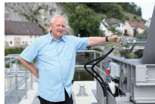
Blick auf die modernisierte Wehranlage in Rechtenstein
