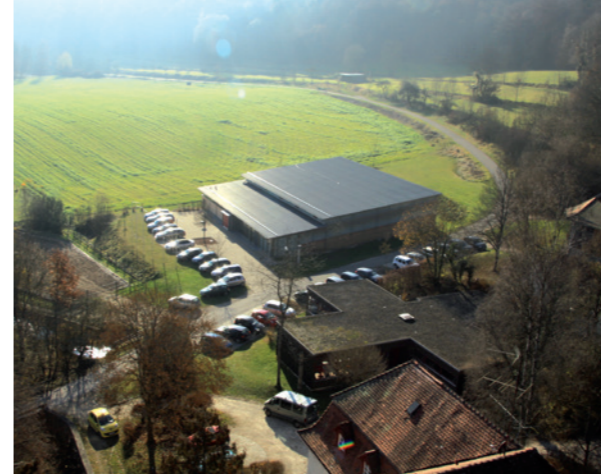
Am Rande des Geländes gelegen – und doch mitten drin! Die Sporthalle „rundet die Liegenschaft ab“.
